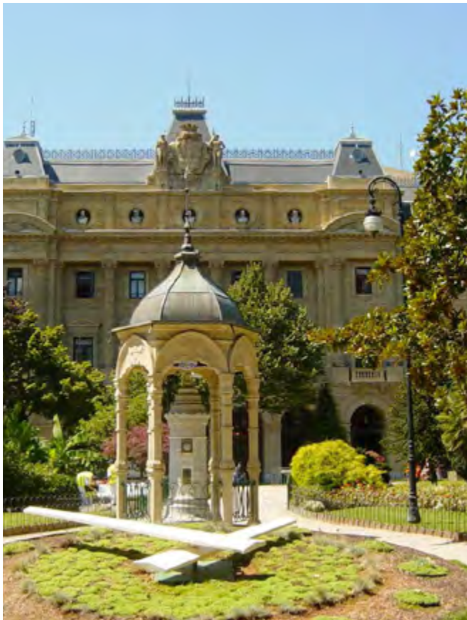
DISEÑO Y EJECUCIÓN DE LA REHABILITACIÓN DE LA SALA DE MÁQUINAS DEL EDIFICIO DE PALACIO, SEDE DE LA DIPUTACION FORAL DE GIPUZKOA 2013 - San Sebastián Cliente: Diputación Foral de Gipuzkoa
