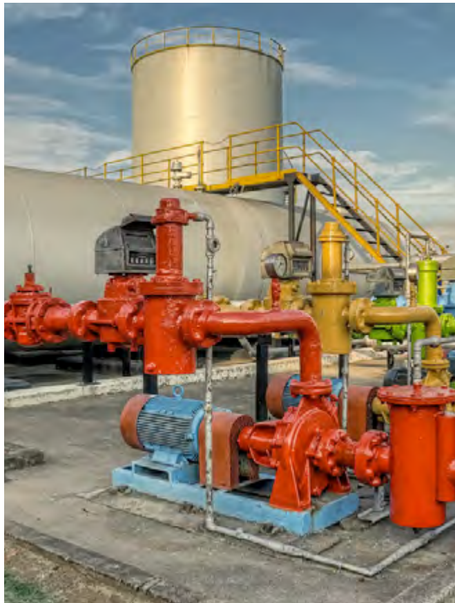
PITAGORAS - PROYECTO EUROPEO DE DESARROLLO DE REDES DE DISTRITO DE ENERGÍA TÉRMICA DE BAJA TEMPERATURA Y GENERACIÓN DE POTENCIA DE FUENTES RESIDUALES Y RENOVABLES 2013-2017 - Distintos emplazamientos de Europa Cliente: Comissió Europea
